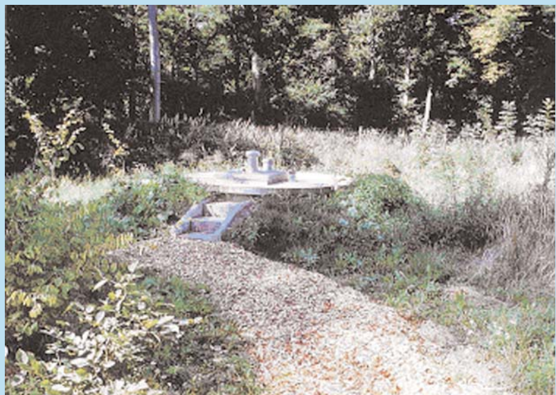
Abb. 2: Schluckbrunnen zur Infiltration von Oberflächenwasser (Foto: Hessenwasser GmbH & Co. KG).
