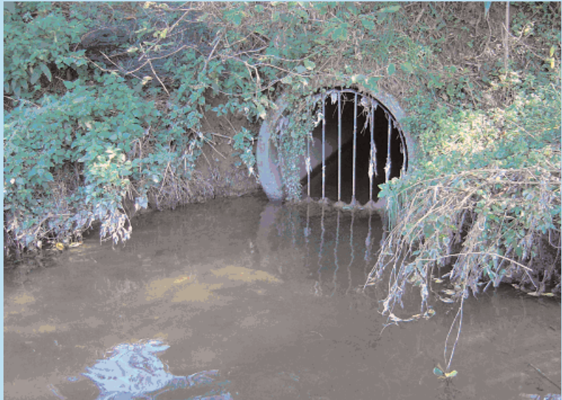
Abb. 1: Mischwasserentlastung (Foto: IMKE BREMER, HMULV).
