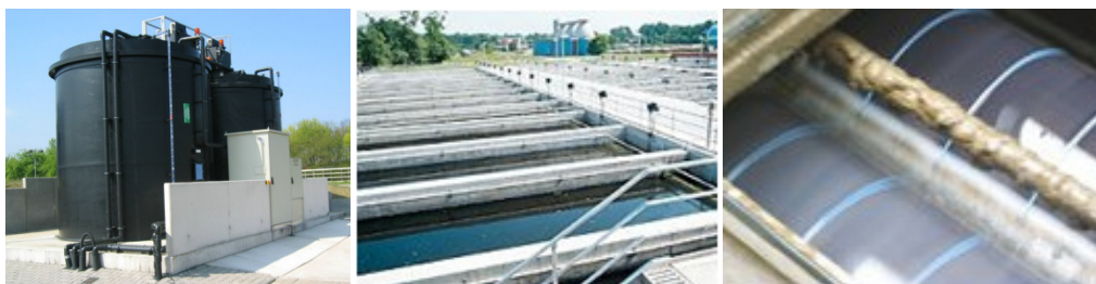
Abb. 1: Maßnahmen zur Reduzierung des P-Eintrags aus kommunalen Kläranlagen (v.l.n.r. Fällung, Flockungsfiltration, Mikrosiebung)
