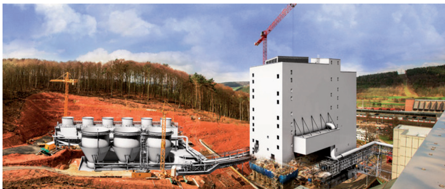
Kainit-Kristallisations-Flotations-Anlage (KKF-Anlage), K + S 2016
