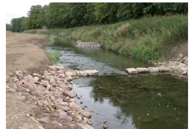
Rückbau einer Wehranlage an der Ilme bei Einbeck
