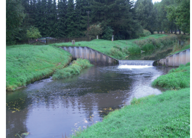
Wehranlage an der Ilme bei Einbeck
